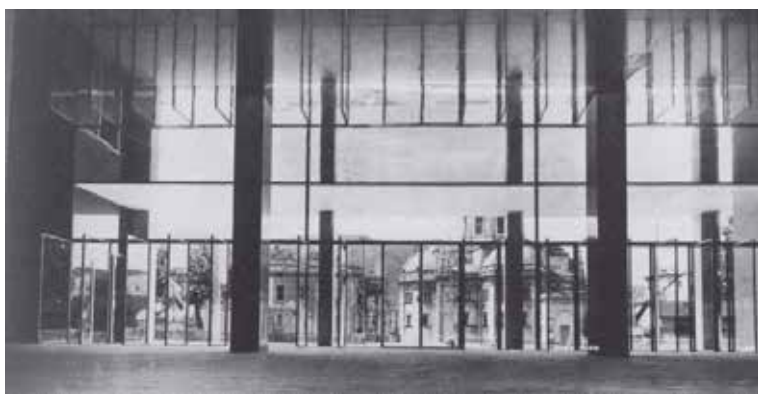
Fig. 8. Casa del Fascio di Como, 1936 (Giuseppe Terragni). Vetrata d'ingresso: diciotto ante vetrate apribili simultaneamente per collegare lo spazio esterno alla corte trasformata in luminosa piazza coperta.
