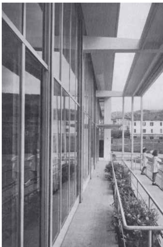
Fig. 16. Asilo Sant'Elia di Como, 1937, loggia di ingresso (Giuseppe Terragni).
