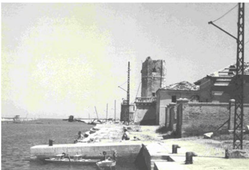
*Fig. 10. Veduta del porto canale di Rimini prima della ricostruzione: particolare del faro in muratura e dei muri di sponda del molo. Ufficio del Genio Civile di Rimini - Sezione autonoma per i danni di guerra, Busta n. 1480, Serie 7, Foto 1. Moretti Film, Esec. ca. 1943-1946, fotografia B/N: gelatina a sviluppo 175 × 125 mm.*
