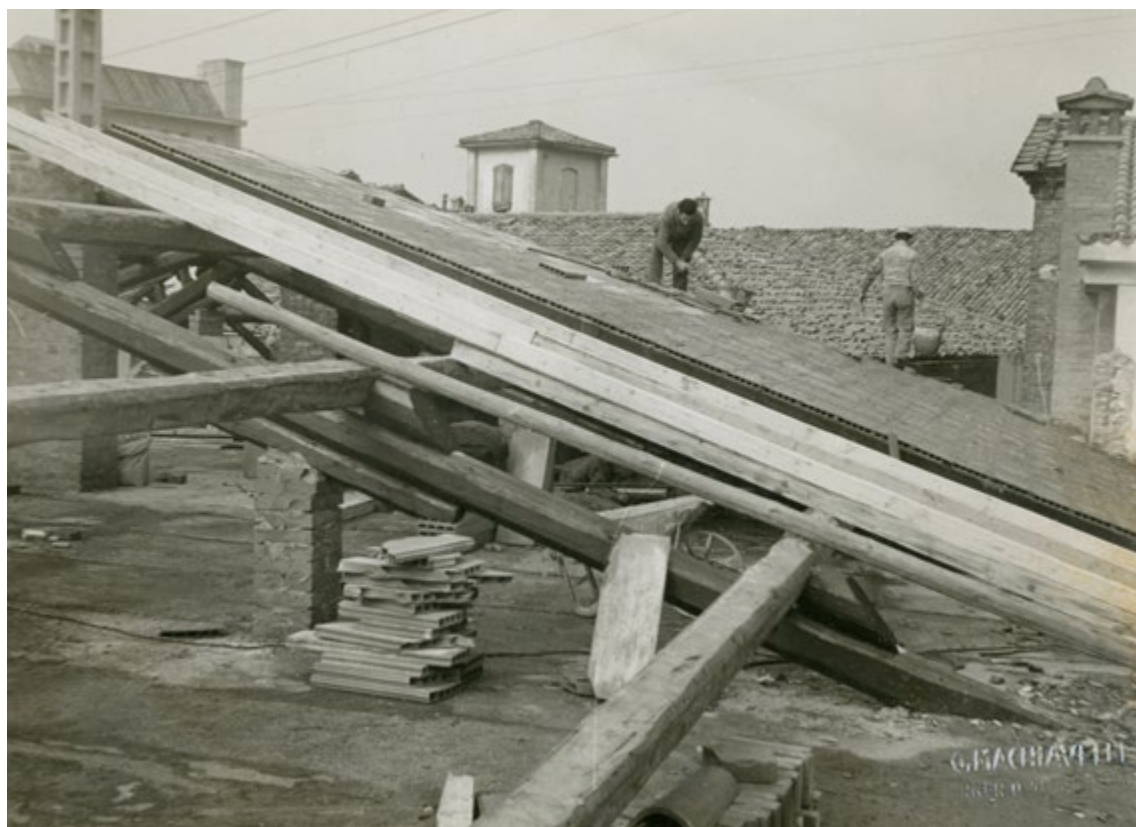
Fig. 10. Veduta del cantiere con operai intenti alla ristrutturazione del terrazzo di Palazzo Poggi dopo gli eventi bellici. Ufficio del Genio Civile di Bologna, Busta n. 74/2, Titolo 3 - Classe B, Sezione staccata del Genio Civile per l'Università di Bologna - Posizione 304. Studio Fotografico G. Macchiavelli, Esec. 1951, fotografia B/N: gelatina a sviluppo 127 × 177 mm.
