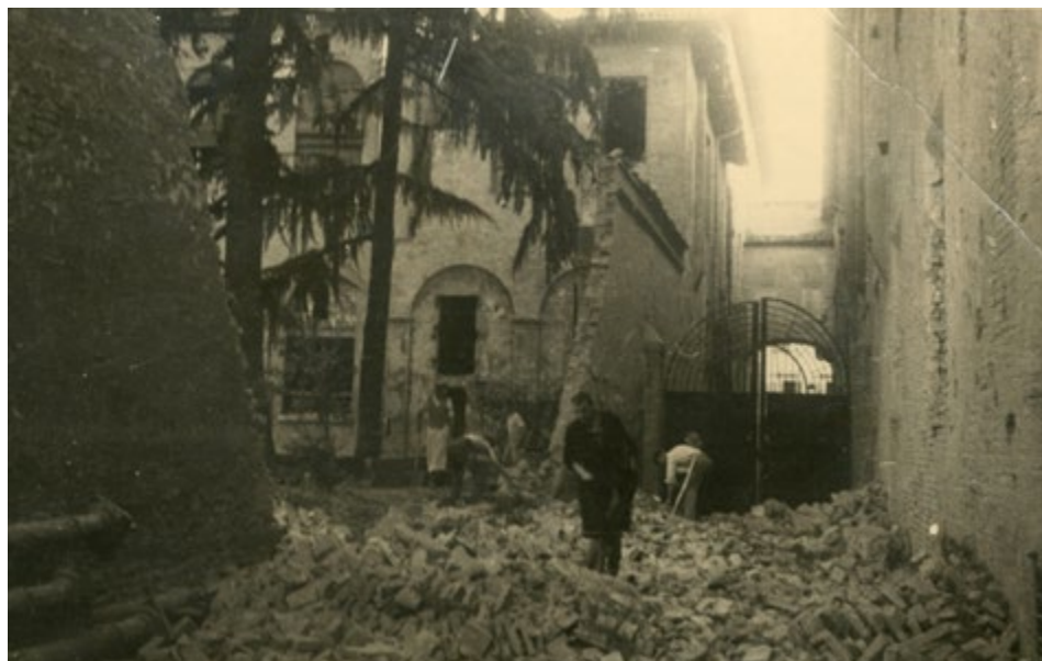
Fig. 9. Bologna, Via San Vitale n. 59: Clinica odontoiatrica dell'Università, nota anche come ex Convento di Santa Maria. Particolare dei danni alle opere murarie del cortile interno, dopo il bombardamento del 12 settembre 1944. Ufficio del Genio Civile di Bologna, Busta n. 70, Titolo 3 - Classe B, Sezione staccata del Genio Civile per l'Università di Bologna - Posizione 241. Anonimo, Esec. [1944-1945], fotografia B/N: gelatina a sviluppo 90 × 140 mm.
